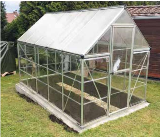
**Auf diesem Bild ist der Stahlrahmen gut zu erkennen, das Betonfundament ist natürlich nicht erlaubt.**
